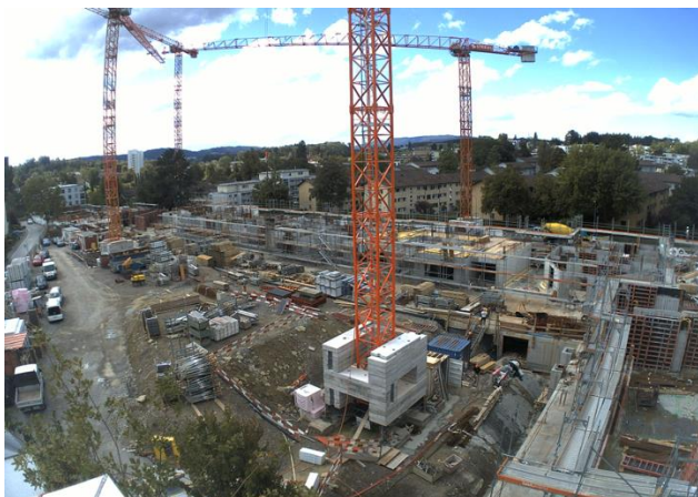
Webcam auf unsere Baustelle an der Birchstrasse in Seebach.
