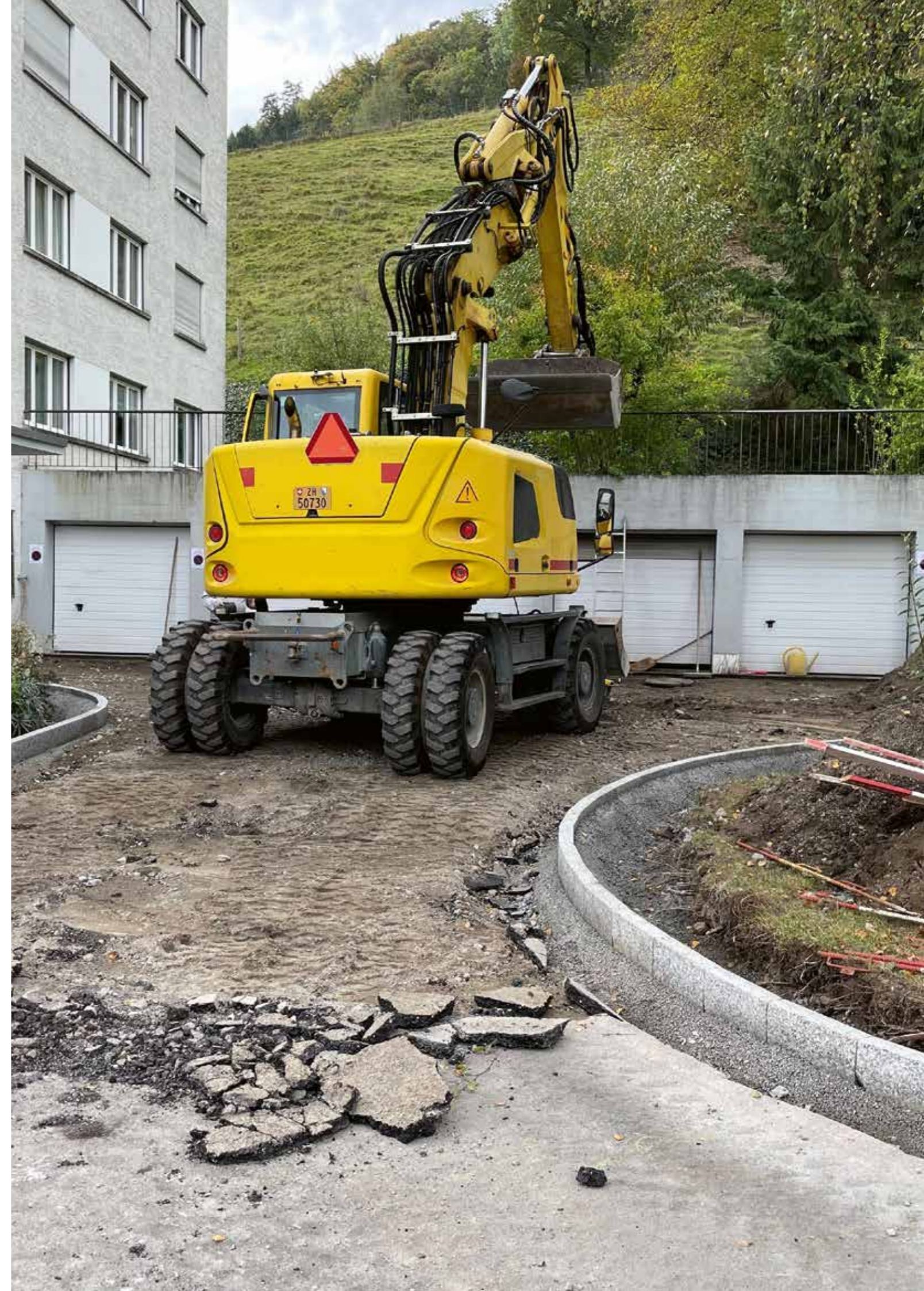
Belagssanierung Garagenvorplatz bei Zwirnerstrasse 74
