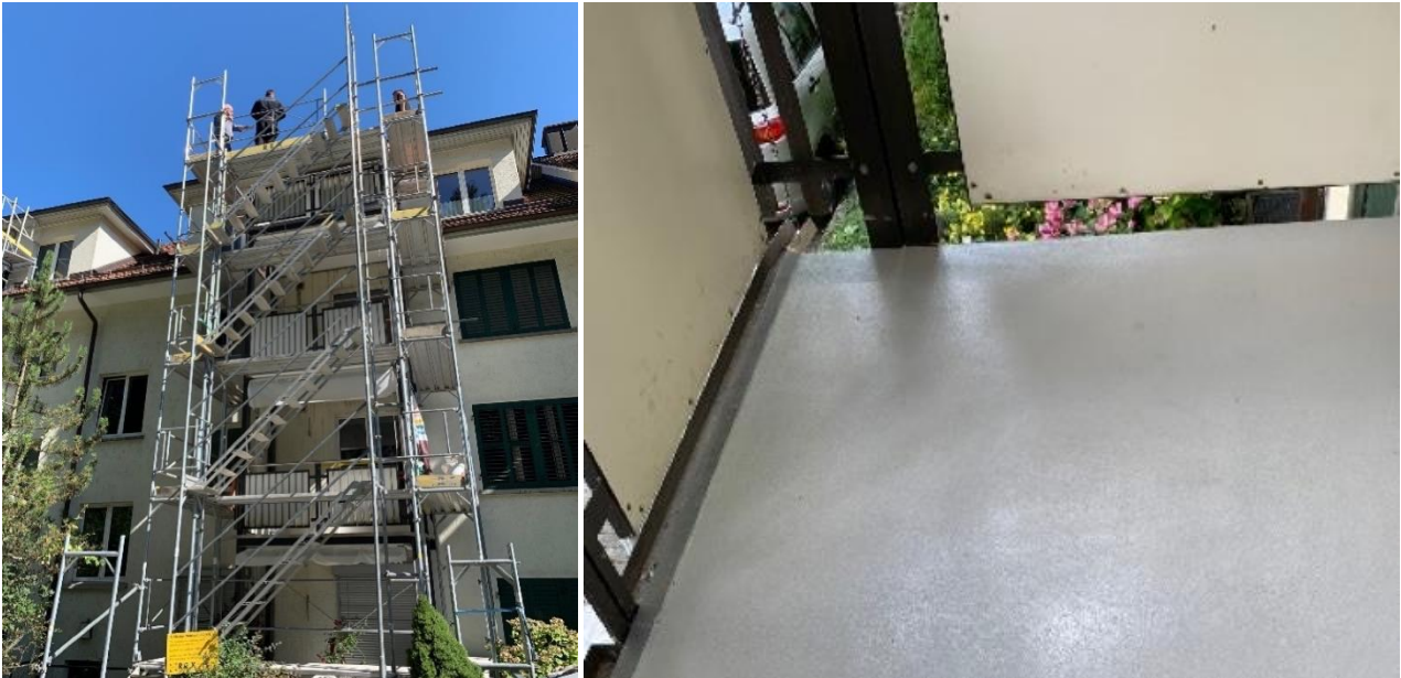
Links das erforderliche Baugerüst, rechts ein sanierter Balkonboden mit neuer Ablaufrinne.
