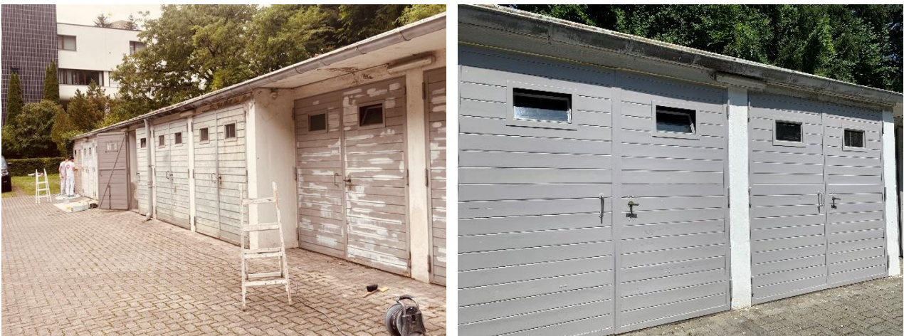
Die Flügeltore der Einzelgaragen wurden instandgesetzt und erhielten einen neuen Anstrich.
