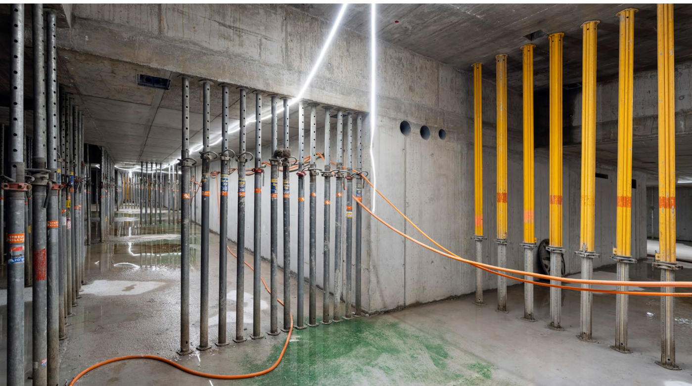
Tiefgarage im Rohbau
