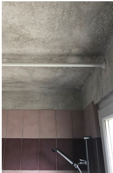
Abb. 3: Grossflächiger Schimmelbefall
