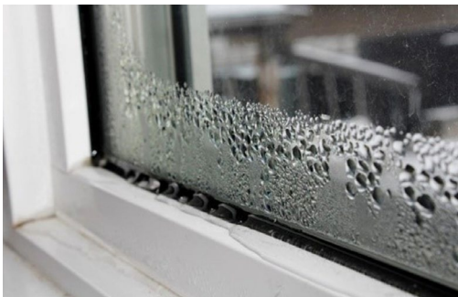
Abb. 1: Kondenswasser am Fenster
